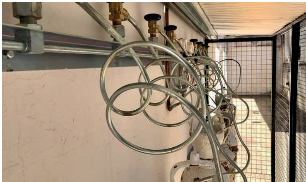
Giménez, de Equigas Internacional, dio una charla sobre el tema de las pérdidas en tuberías, en Colombia.
